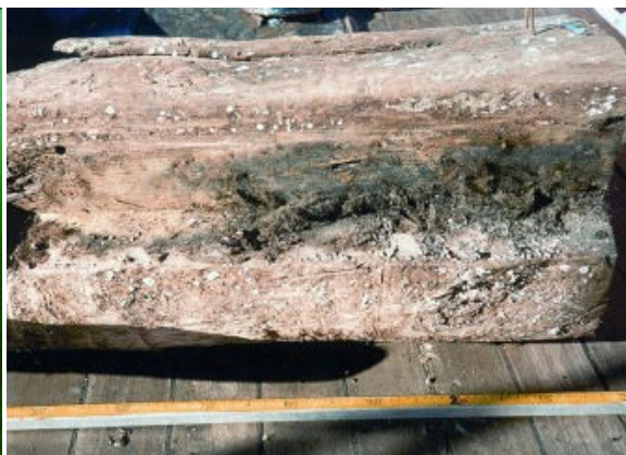
Ryc. 16. Uszczelnienie pasa przystępkowego (fot. T.Bednarz).
